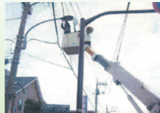
街路灯のランプの取替
