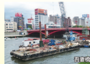
長寿命化工事 (施工中)
