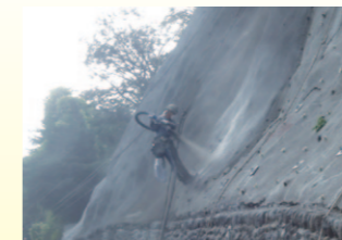
モルタル吹付工 (施工中)
