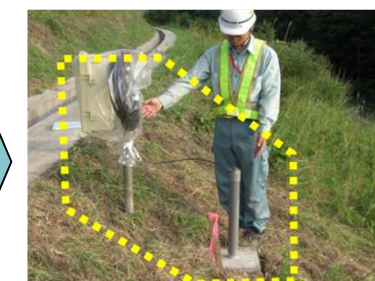
地下水位の観測状況
