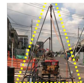
観測井戸の設置状況
