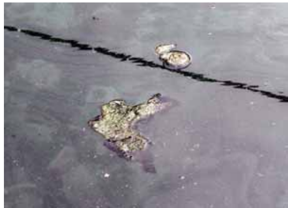
水面に浮かんだ油みたいなものの拡大写真
