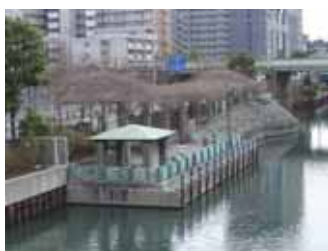
東側河川の防災船着場 （岸壁型）
