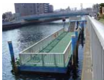
西側河川の防災船着場 （水位変動があるため、 浮棧橋式）
