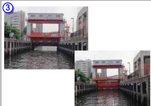
扇橋閘門を通過
