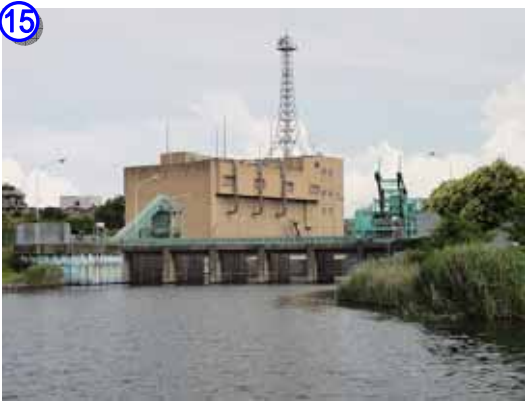
木下川排水機場
