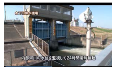
木下川排水機場
