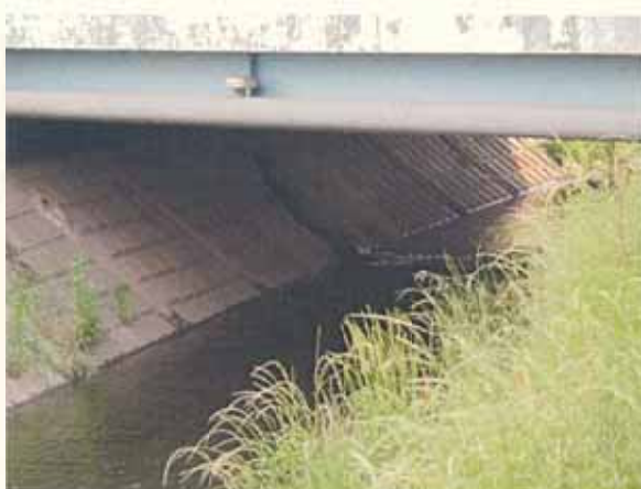
東芝中橋右岸の工場排水 4,000t/日で最大の水源となっている。
