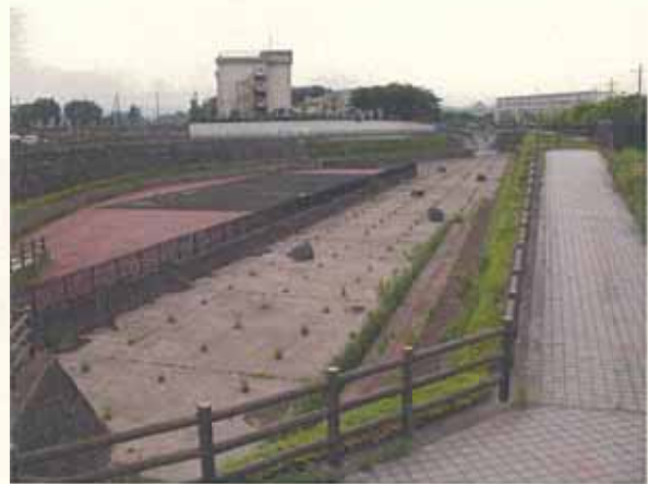
芝中調節池にて。40,000t の貯水能力がある。
