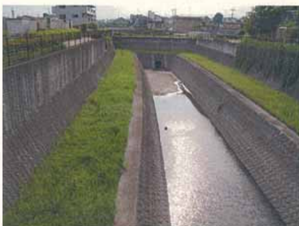
庚申橋調節池にて。23,000tの貯水能力があり、65mm/hの雨に対応するために深く造られた。
