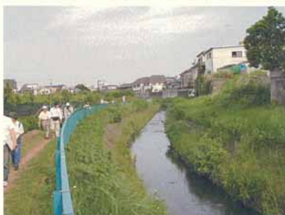
砂の川橋付近から下流を望む
