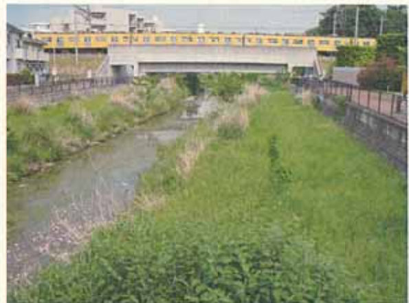
前野橋から見た西武国分寺線橋梁付近の状況
