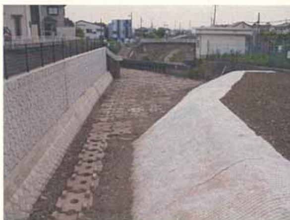
上砂橋から見た上流側の上砂・神明調節池
