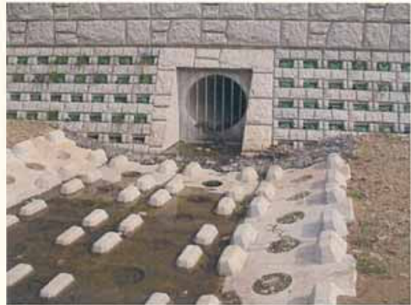
西武多摩湖線橋梁上流側左岸の排水口。砂れき層に浸透した雨水を流している。
