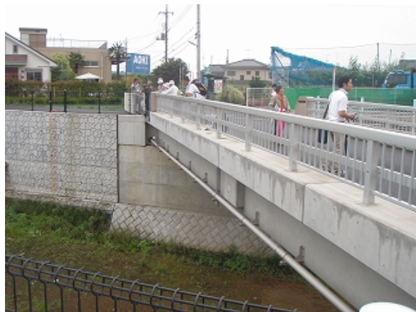
空堀川 新砂の川橋 新砂の川橋から空堀川の整備状況を確認。
