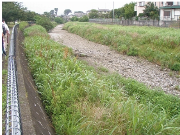
空堀川 御成橋上流側 空堀川河道の状況。
