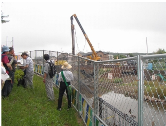
空堀川 奈良橋川合流地点 空堀川整備工事の現場を見学。
