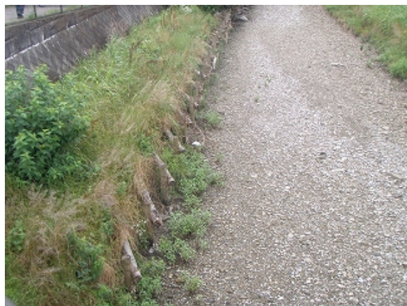
空堀川 なかよし橋上流側 なかよし橋上流の空堀川の河床状況。
