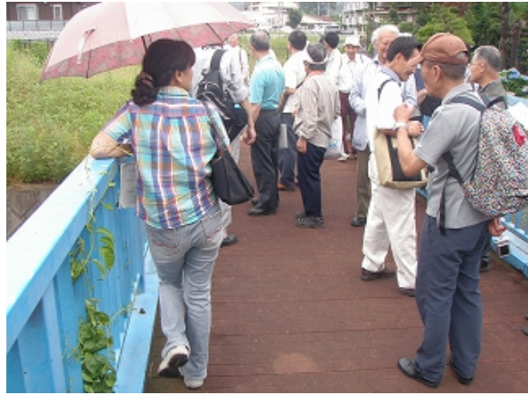
武蔵村山河道内調整池 武蔵村山河道内調整池周辺を徒歩にて見学。
