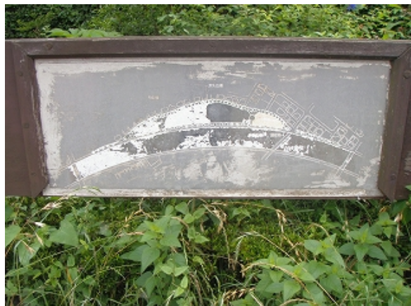
空堀川 右岸芝生広場 芝生広場内の表示板の状況。
