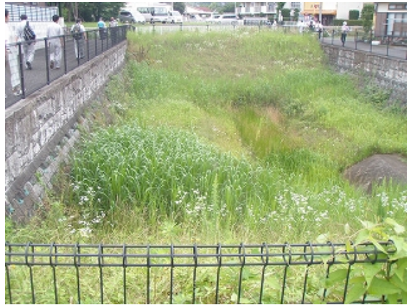
武蔵村山河道内調整池 武蔵村山河道内調整池の様子。
