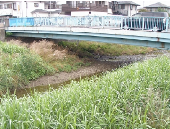
空堀川 御成橋 上流、右岸側から見た御成橋。
