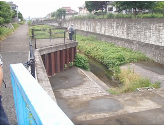
武蔵村山河道内調整池 武蔵村山河道内調整池の様子。
