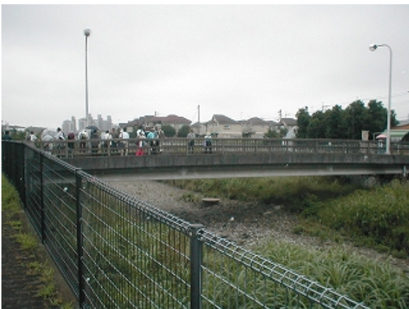
空堀川 土橋 右岸下流側からみた土橋。
