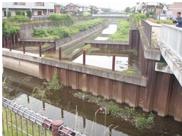
空堀川 新丸山一の橋 旧川との交差箇所。
