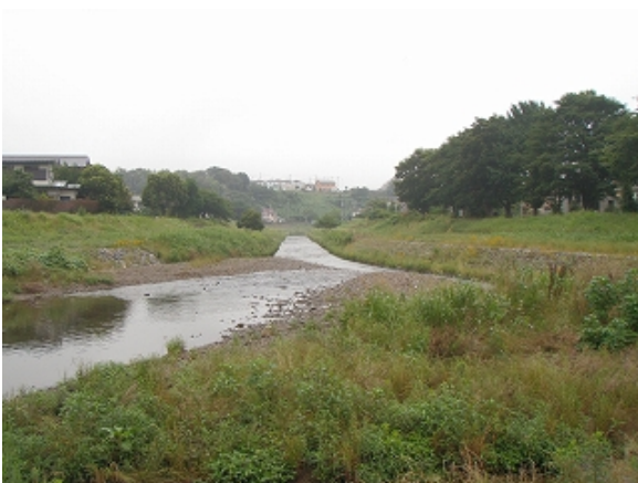
柳瀬川・空堀川合流点下流側 合流地点下流(柳瀬川)の様子。
