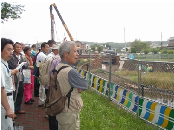
空堀川 奈良橋川合流地点 空堀川整備工事の現場を見学。
