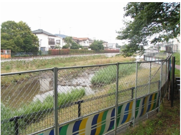
空堀川 奈良橋川合流地点 空堀川整備工事現場の下流側。
