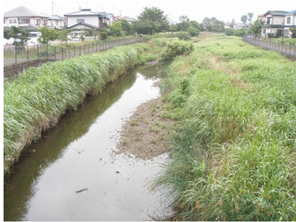
空堀川 御成橋上流側 御成橋上から空堀川の上流を望む。
