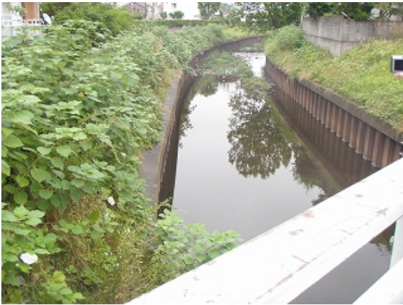
空堀川 旧川 宮前一の橋付近の空堀川旧川。
