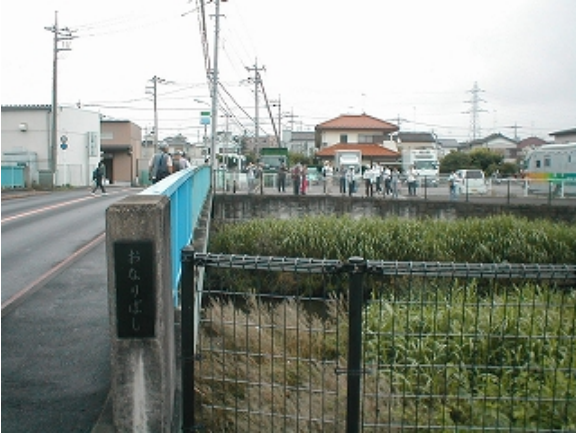
空堀川 御成橋 左岸側から見た御成橋。
