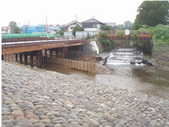
柳瀬川・空堀川合流点 河川工事現場(中断中)の様子。
