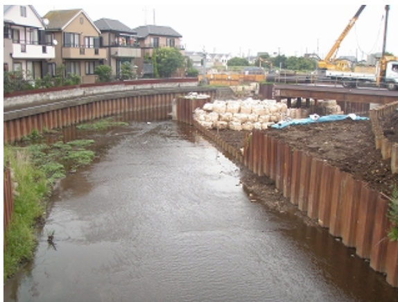
空堀川 奈良橋川合流地点 上流側から見た空堀川整備工事現場。
