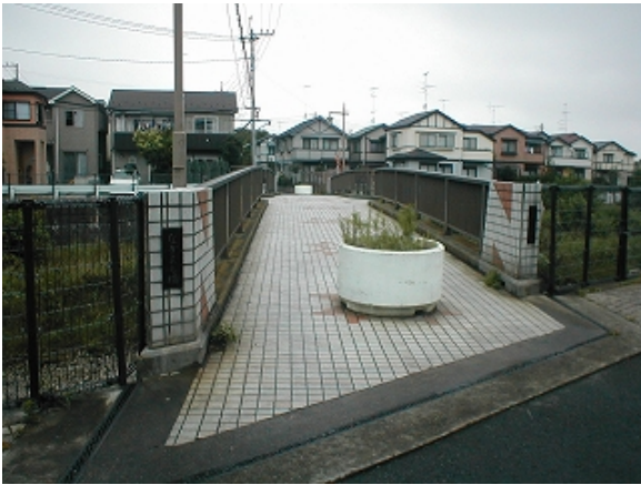
空堀川 なかよし橋 右岸側から見たなかよし橋。
