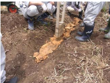
水路底部への粘性土張り付け
