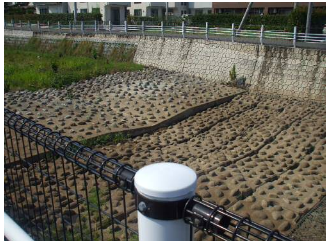
施工済護床工
