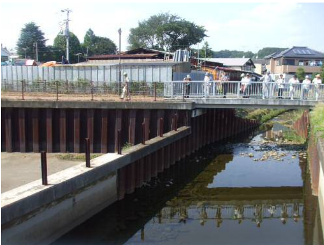
旧川との交差部
