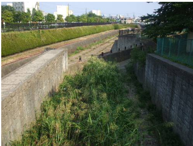
上流側越流部
