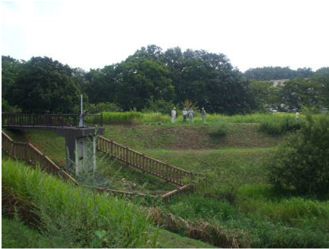
築堤と排水樋管
