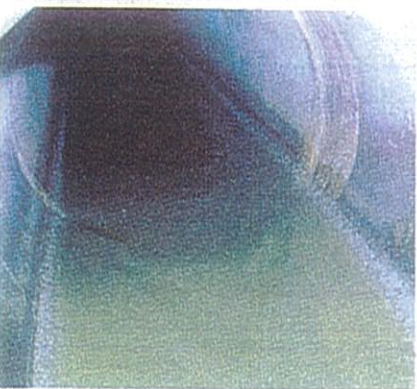
下水道管の内部
