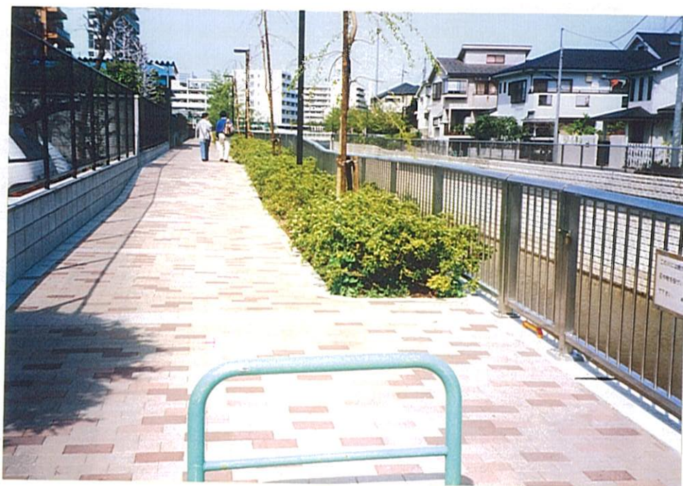
富士見橋下流左岸の状況
