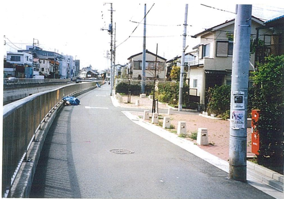
西田中橋上流左岸の状況
