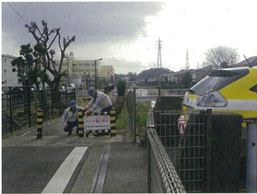
進入禁止柵の点検の様子
