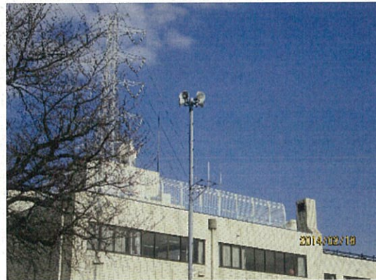
防災行政無線(町田市中町)
