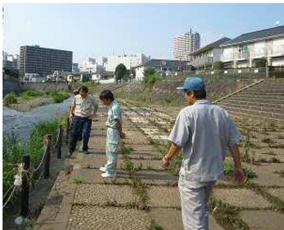
親水護岸を点検
