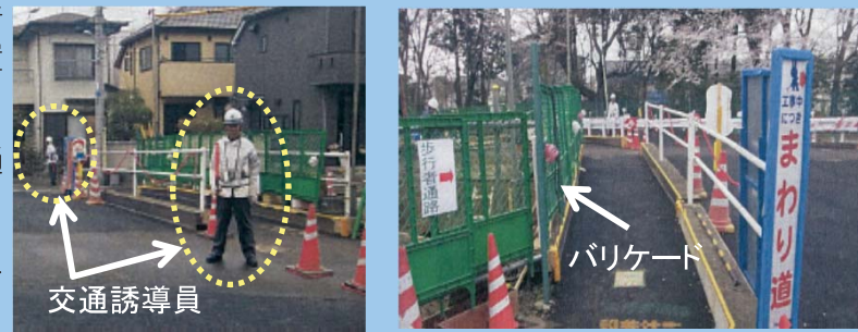
写真 放5(久我山区間)での安全対策(左:交通誘導員の配置、右:バリケード等の設置)
