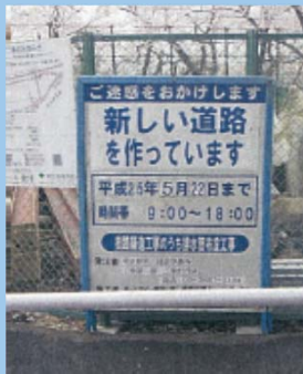
写真 放5(久我山区間)での工事看板設置
