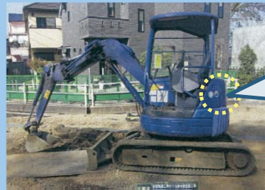
写真 放5(久我山区間)での建設機械
