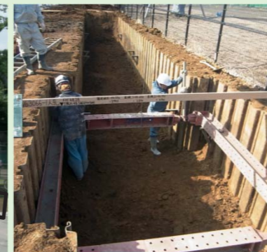
排水管工事を施工した箇所
