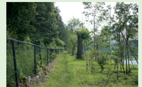
写真 玉川上水緑道工事の状況 (上:工事後の久我山1丁目の中央高速付近(H25.7)) (下:工事後の岩通ガーデン付近(H25.7))
