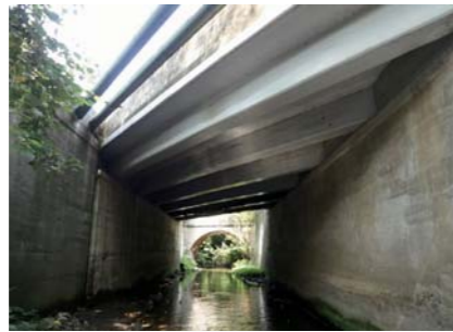
写真 牟礼橋下の法面
