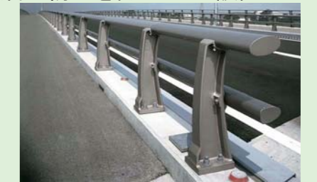
写真 高欄(車両防護柵)
