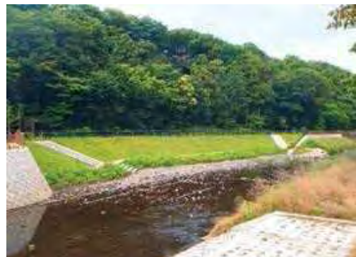
境川(町田市森野) 背後にある相模原市の公園と連携を図り、親水性に配慮した緩傾斜護岸を整備。地元の方々にも親しまれている。
