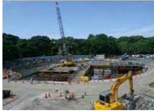
善福寺川調節池(貯留量約35,000m 3 )(杉並区成田西四丁目地内) 善福寺川上流の浸水被害を早期に軽減するため、都立善福寺川緑地内に貯留量約35,000m 3 の地下式の調節池を整備している。
