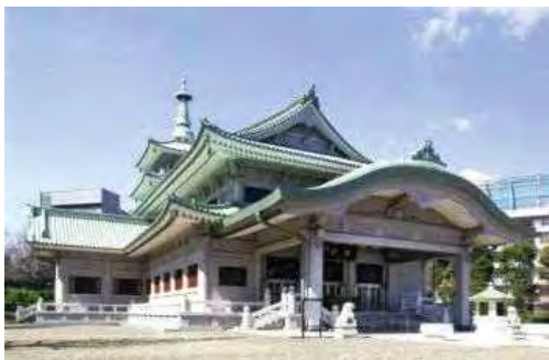
横網町公園 慰霊堂・慰霊塔(墨田区) 昭和5年に建設された建築物。耐震補強や老朽化した設備等の改修のため、3箇年かけて工事を実施した。
