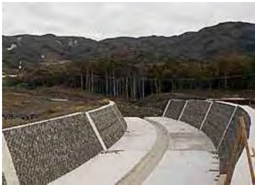
特定緊急砂防事業(導流堤整備)(大金沢 大島) 平成25年の土砂災害からの復旧に向け、現在、短期対策(平成26年度～平成28年度)として導流堤及び山腹工の工事を実施している。
