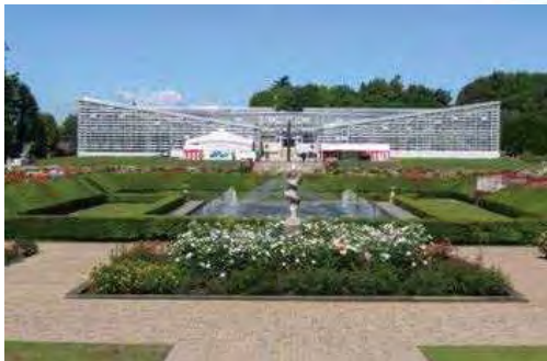
神代植物公園 大温室(調布市) 老朽化した大温室の改修工事を実施した。リニューアルオープンには記念式典を開催した。(平成28年5月12日)
