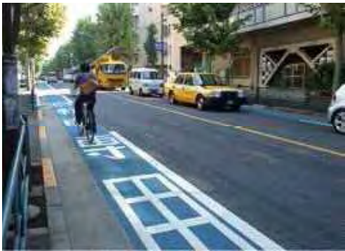
自転車走行空間整備事業(渋谷区幡ヶ谷 旧玉川水道道路) 自転車レーンや広い歩道を活用した自転車歩行者道など、東京の道路事情に応じた整備手法により、安全で快適な自転車走行空間の整備を進めている。
