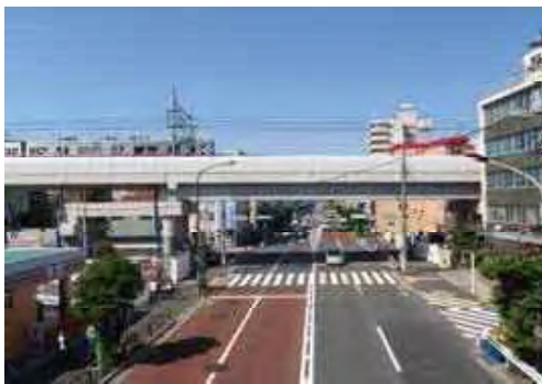
京成押上線(押上駅～八広駅間)連続立体交差事業 平成27年8月に全線高架化し、環状第4号線(明治通り)の踏切を含む6箇所の踏切を除却した。現在は、側道整備を進めている。
