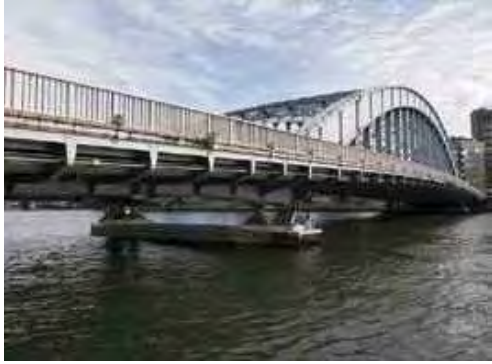
橋梁の長寿命化事業 (永代橋:中央区新川一丁目～江東区永代一丁目地内) 隅田川に架かる国の重要文化財である永代橋は、耐震性や耐久性などの向上を図る長寿命化工事を実施している。
