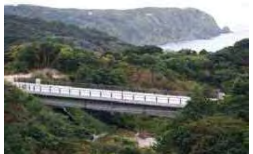
一般都道長浜多幸線(神津島村) 鍛冶山地区から鉄砲場地区の500m区間について平成28年4月に交通開放した。これにより、既設村道も含めた区間でダブルルートが確保され、地域の防災力の向上などが図られる。
