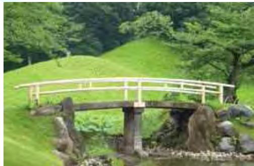
小石川後樂園 石橋(文京区) 平成23年の大震災により損傷した石橋ならびに周辺石積について、古写真等を参考に修復工事を実施した。
