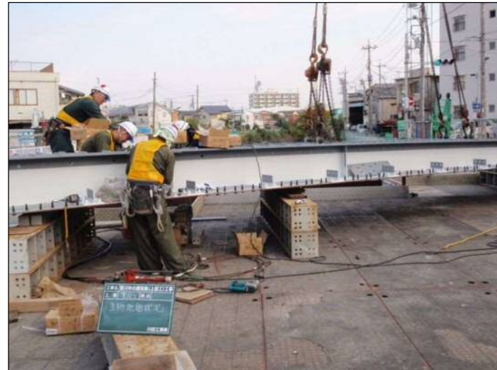
⑤床版工(埋設型枠組立)
