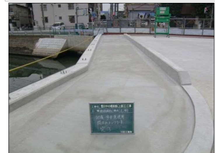
⑥付属物工(地覆・間詰コンクリート打設)
