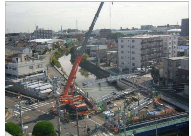
⑤床版工(床版鉄筋組立)
