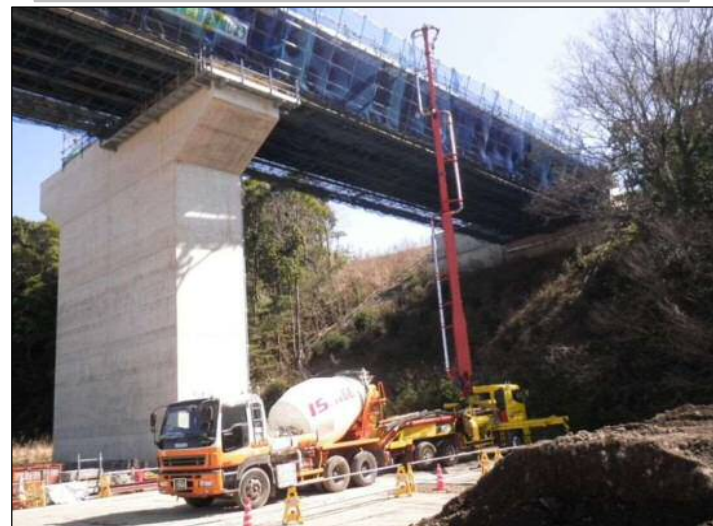
⑤床版工(床版コンクリート打設)
