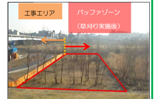
実際の工事で設置したバッファゾーン
