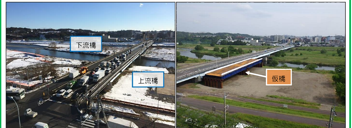
仮橋工事着工前（平成28年1月）
