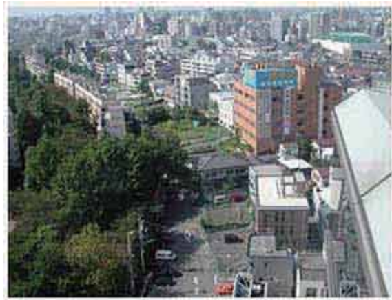
西側工事着手前（平成16年10月撮影）
