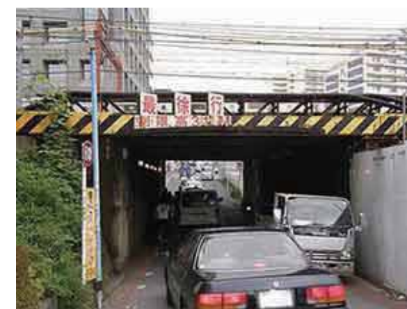
○鉄道ガード下の危険な状況(西側)
