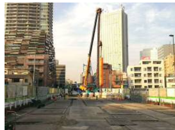
3 工区 （豊島区役所前）
