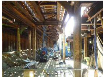
2 工区 （弦巻通り付近地下）
