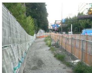
1 工区 （千登世橋中学校前）
