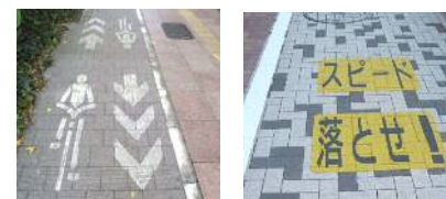
進行方向を示す路面標示
