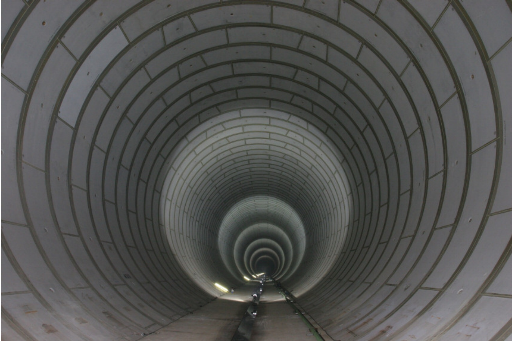
神田川・環状七号線地下調節池（二期工事施工区間）
