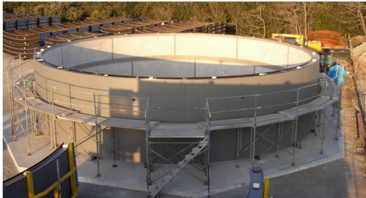
セグメントの仮組立
