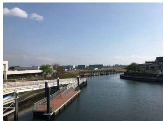
海老取川右岸の様子(天空橋下流)
