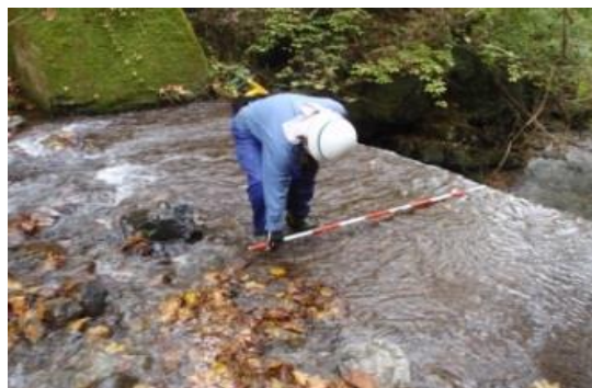
砂防堰堤の点検状況
