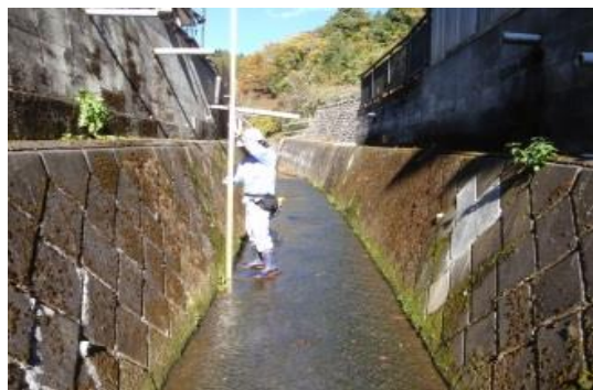
溪流保全工の点検状況
