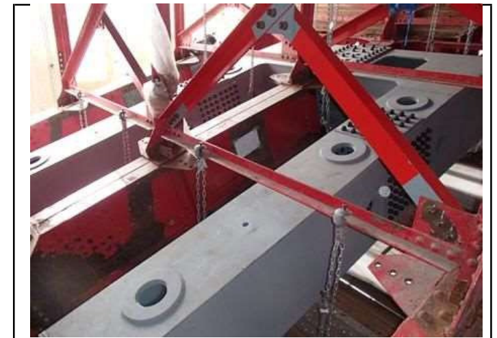
※仮支持材（グレー色の部材）の設置状況
