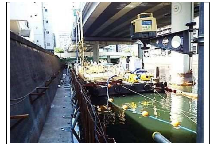
高圧噴射処理工（河床部）
