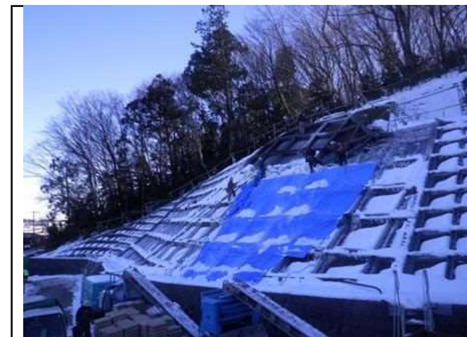
1月22日の降雪による現場内の除雪状況
