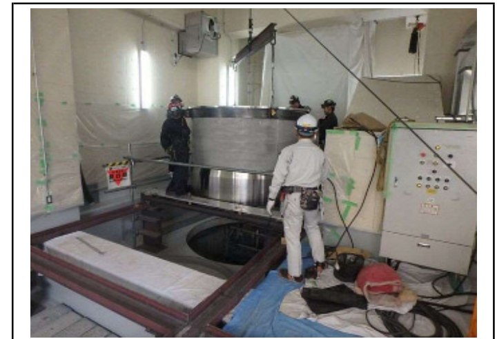
φ2200 SUS製ダクト管据付状況
