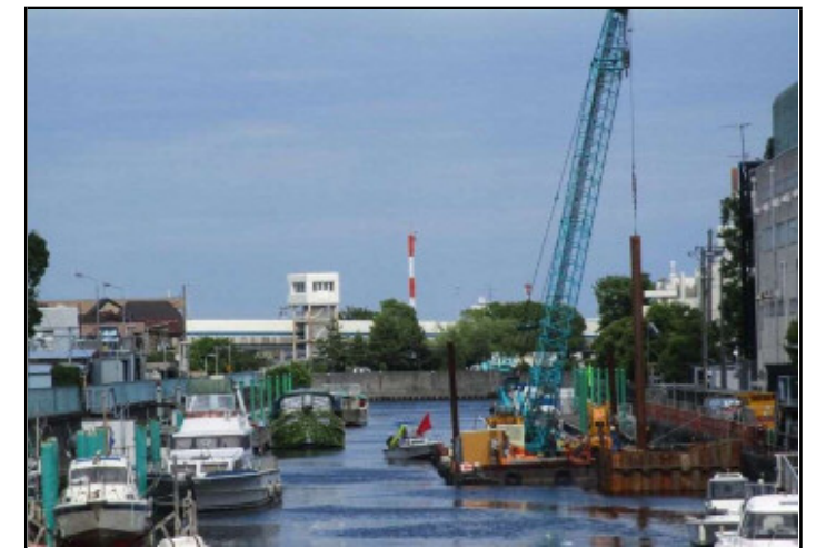
鋼矢板圧入状況（上流）
