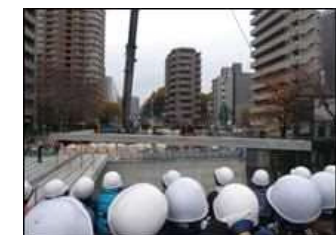
子供達に見守られながら桁の架設
