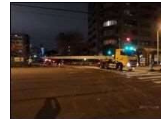
夜間の主桁の搬入
