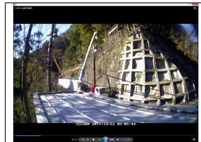
定点カメラにより動画として全工程を記録した。
