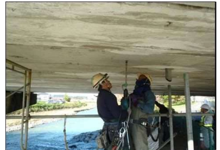
吊り足場用アンカー削孔状況
