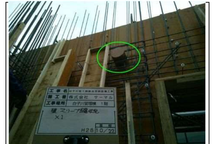
工期内に完了するため建築、電気、機械工事を同時並行で施工を行った
