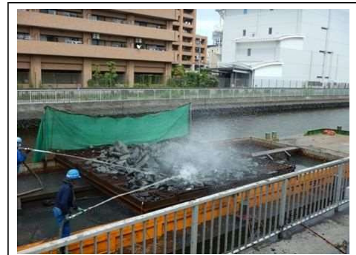
床掘土砂分別状況
