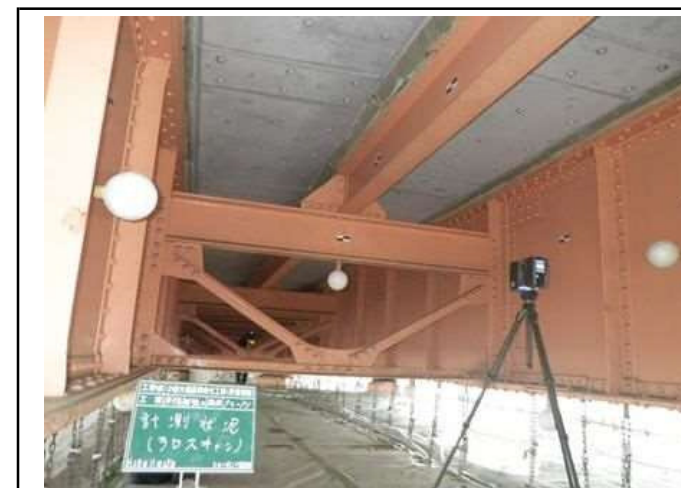
3Dスキャンによる橋梁計測状況
