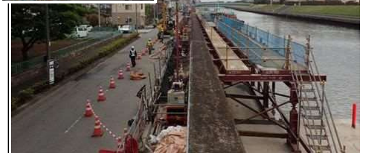
地盤改良施工状況（車線規制・河川内施工架台）
