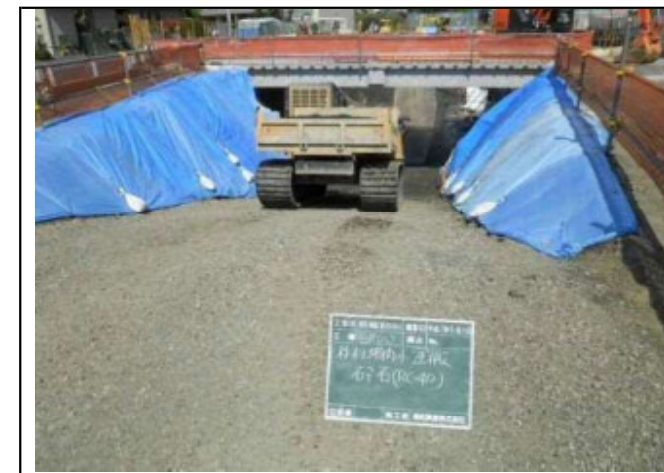
クローラダンプ運搬状況
