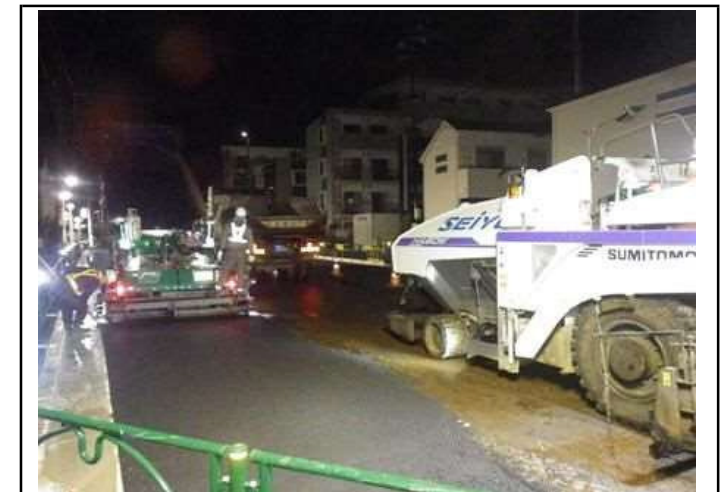
車道舗装表層工Asファイニッシャー2台引施工状況 （※舗装継目による振動防止対策）
