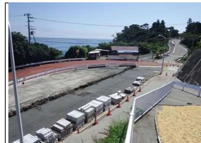
バスの通行が困難な施工中の交通切り替え箇所
