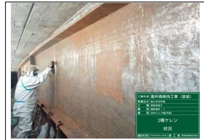
防護服を着用した2種ケレン状況
