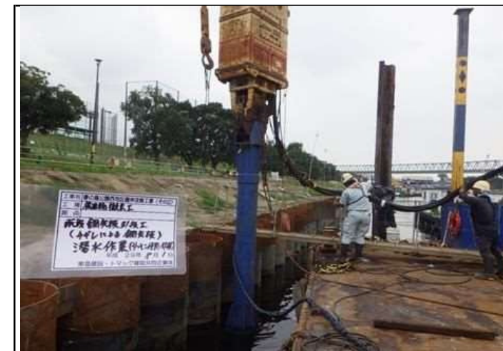
既存鋼矢板の引抜き状況
