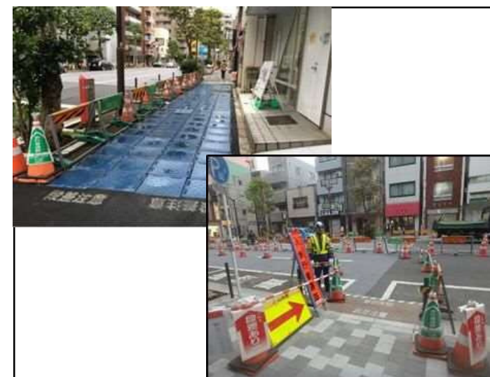
歩道舗装工（歩行者通路の養生、誘導状況）
