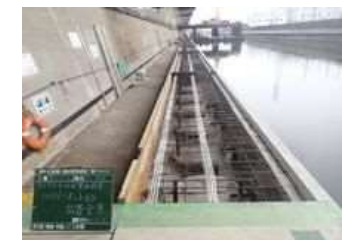
ひび割れ要請ネット
