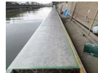
ひび割れ被覆養生
