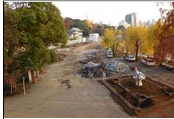
ゾーン整備施工前
