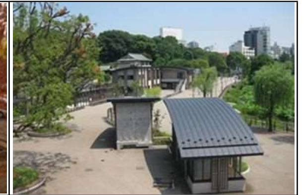
ゾーン整備施工後
