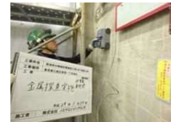
金属探査状況
