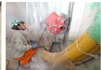
耐震スリット施工状況
