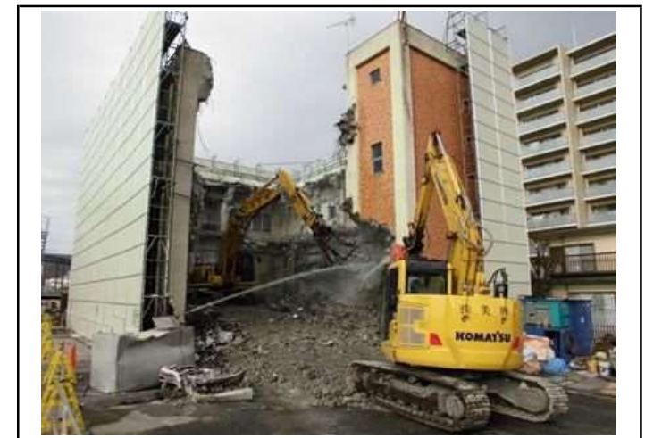
マンションと近接する中での解体作業
