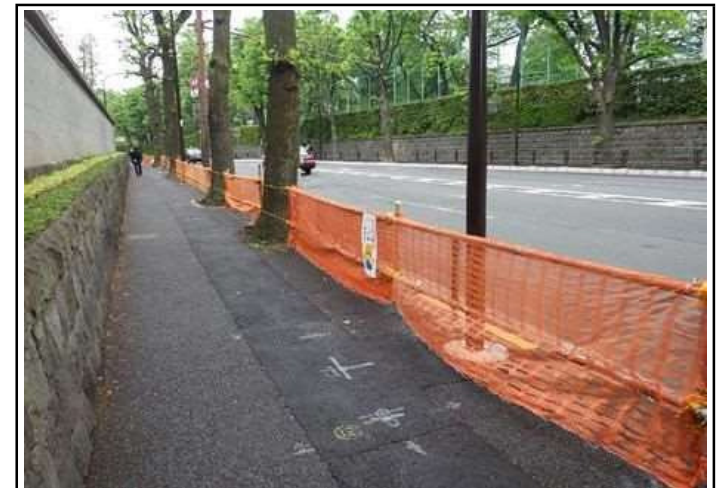
単管柵による仮柵設置状況
